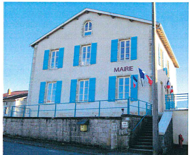
Le bâtiment de la Mairie a été entièrement rénové en 2011
